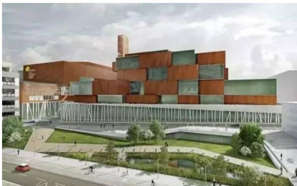
和法国当地标准，如废气的粉尘去除率达到99%以上，二恶英排放几乎为零。排入塞纳河的废水完全符合法国各项排放标准，烟气排放值只有标准的一半。此外所有设备都深藏地下，公众在地上几乎听不到噪声。此外，Issy-les-Moulineaux 垃圾焚烧厂面向塞纳河，背靠火车道。通过河道运输，可使出入焚烧厂的重型垃圾运输车辆的数量从每周426辆减少到320辆，如再加上铁路运输，将可大大缓解公路运输压力，减少汽车尾气排放对环境的污染。
