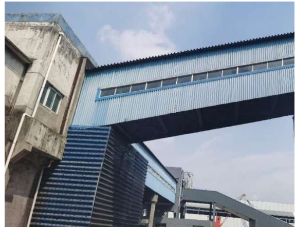
封闭输煤栈桥
