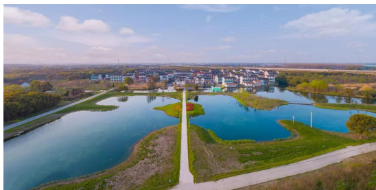
无锡市新吴区荡东片区水生态修复后
