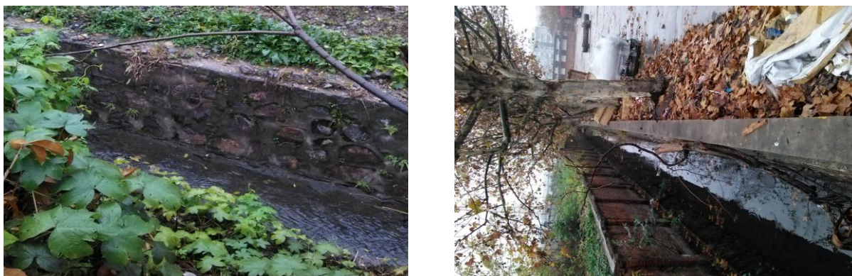
图 4.2.5-2 改移沟渠现状
