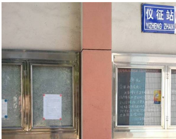
照片 4-3 输油站内宿舍楼第一次公告(1)
