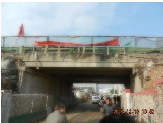
图 2.2-4 康华侨改造施工照片
