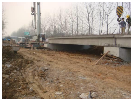
图 2.2-5 绿水湾北路下穿施工照片
