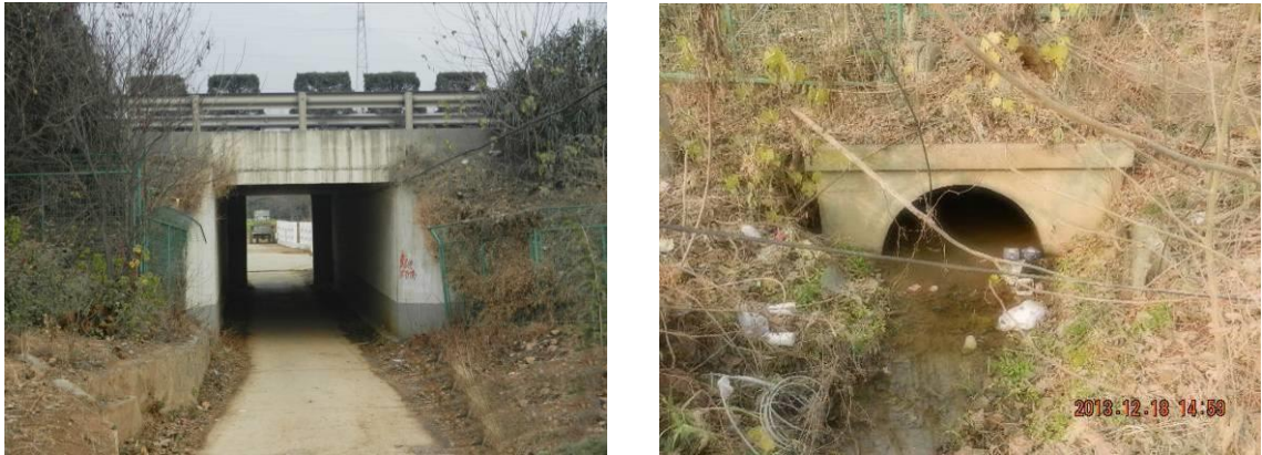
图 2.2-7 沿线通道、涵洞现状照片
