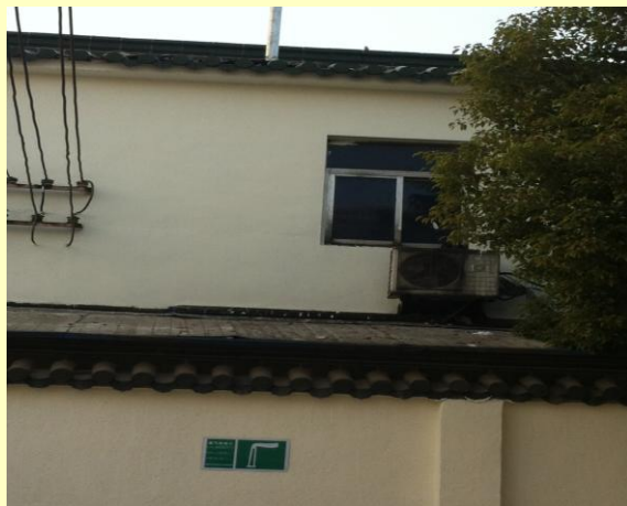
丁蜀镇洑东厂区排气筒 1
