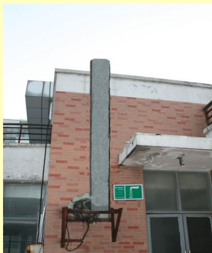
环科园厂区排气筒 2
