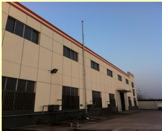
丁蜀镇洑东厂区排气筒 1
