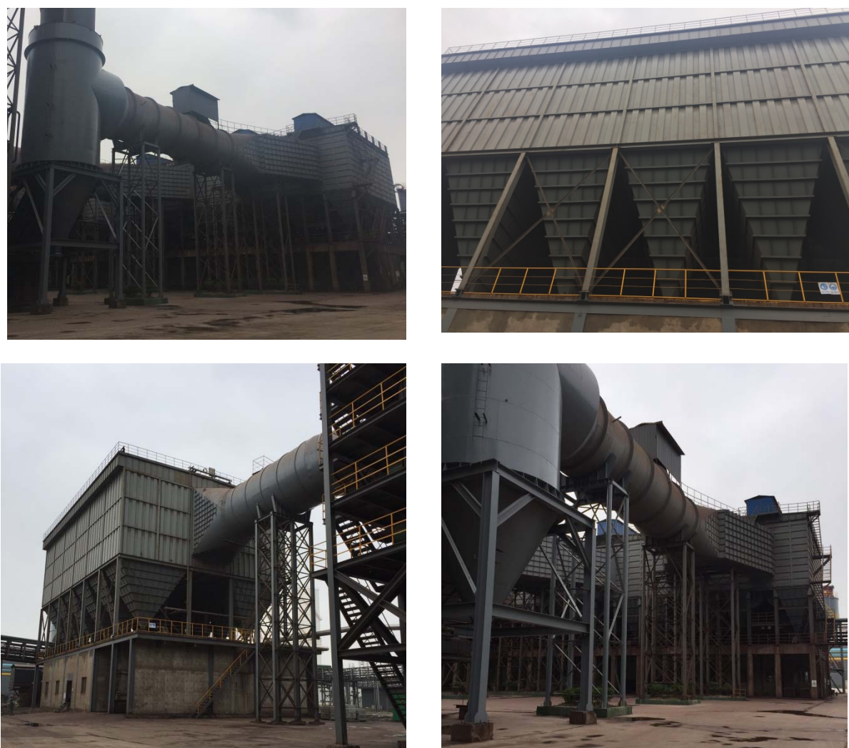
图 7.1-7 脉冲布袋除尘器
