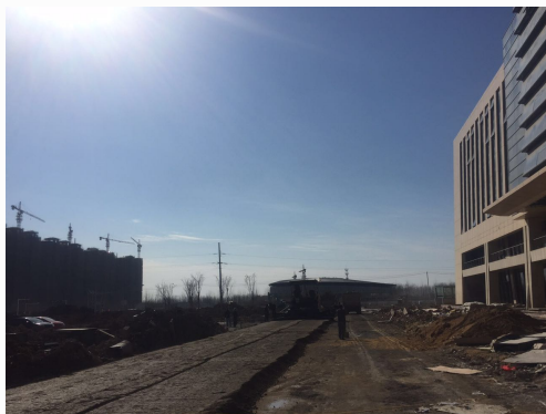
拟建址所在新院区西侧
