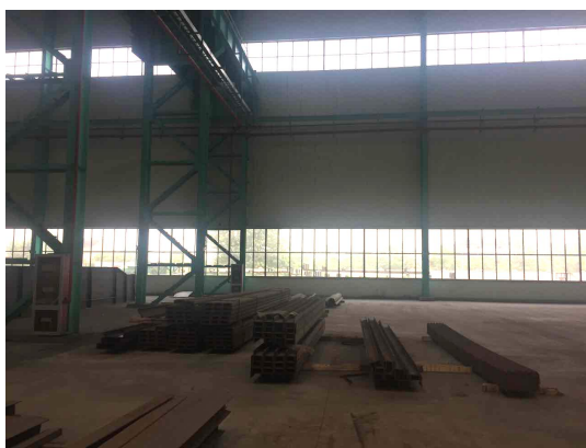
探伤铅房拟建址东侧
