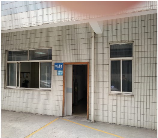
图 8-3 拟建 DSA 机房西侧
