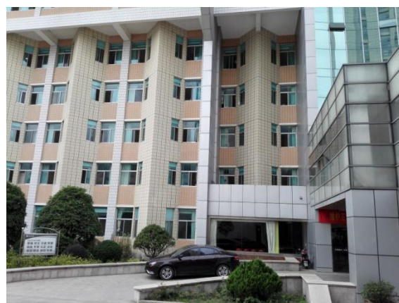
图 8-4 DSA 机房北侧
