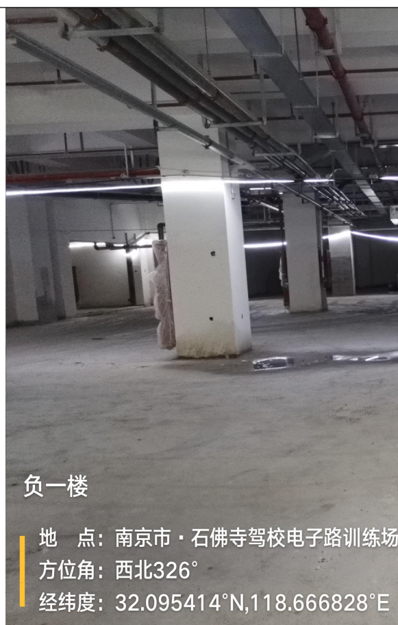
图 8-3 拟建址西南侧（人防停车位）
