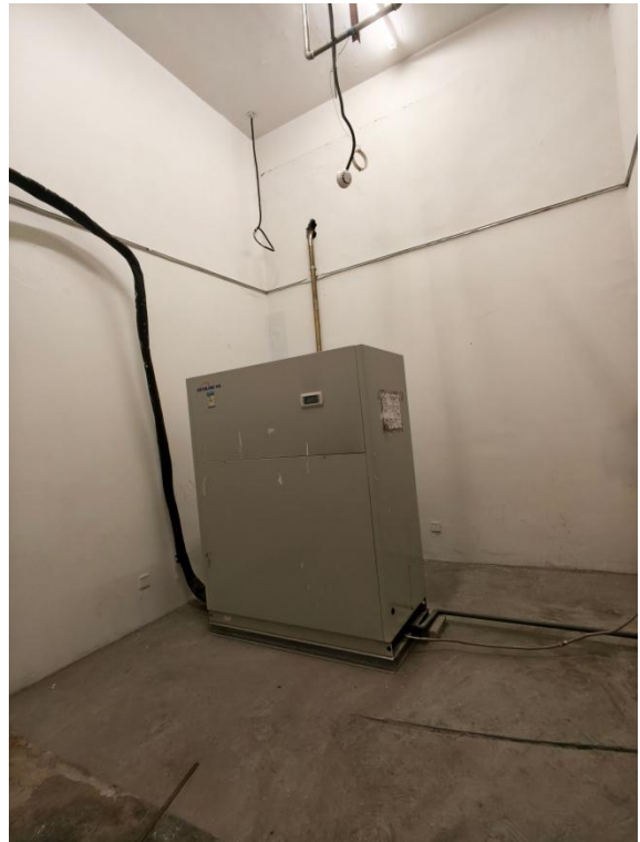
拟建址南侧（设备机房）
