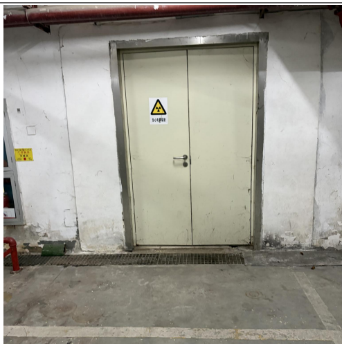
医学影像楼负一层衰变池入口
