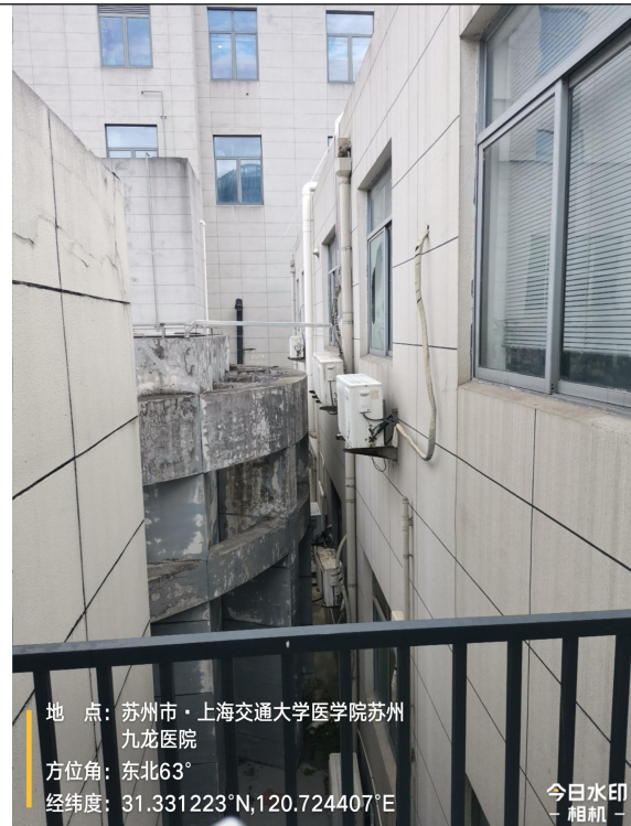
图 8-16 加速器机房上方（不上人屋顶）
