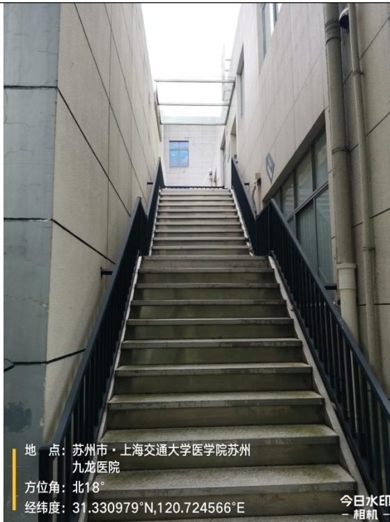
图 8-11 加速器机房东侧（室外楼梯）
