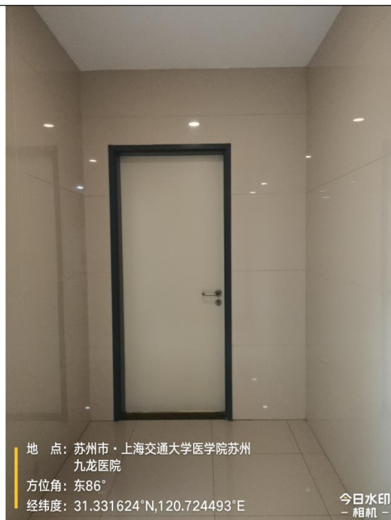
图 8-4 伽玛刀机房南侧（走廊）
