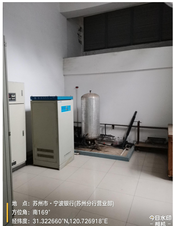
图 8-14 加速器机房西侧（水冷机房）
