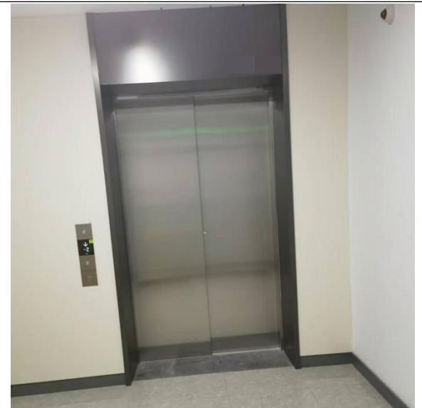
DSA 复合手术室北侧 16#电梯厅
