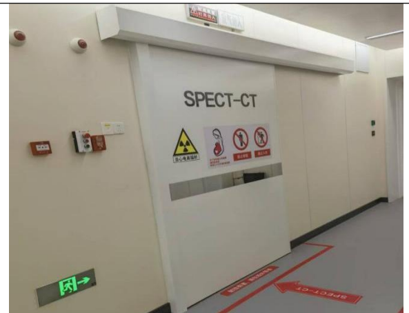
核医学科 SPECT/CT 机房
