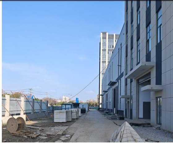
拟建址北侧厂区道路及厂房
