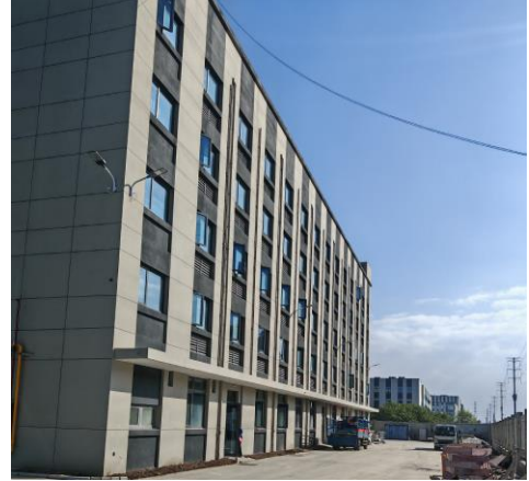
拟建址东侧厂区综合楼
