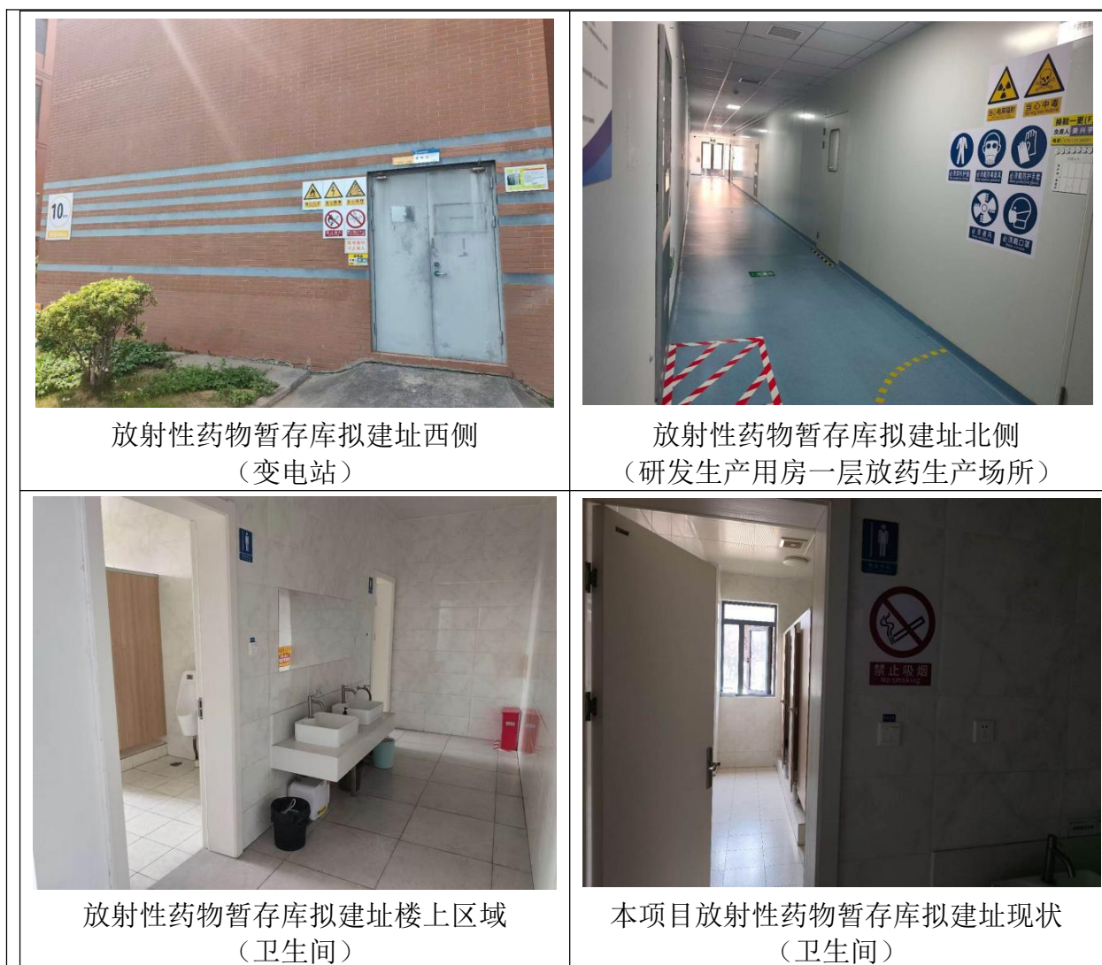
图 8-1 本项目放射性药物暂存库拟建址及周围环境现状图
