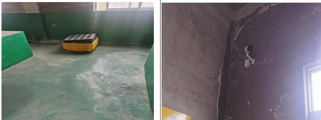
图 3.7-3 危险废物贮存库
