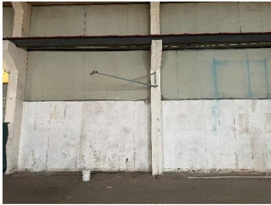
探伤房拟建址南侧
