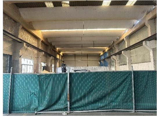
探伤房拟建址东侧
