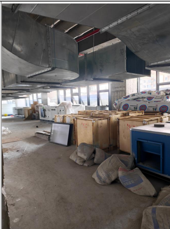
拟建址上方（净化机房）
