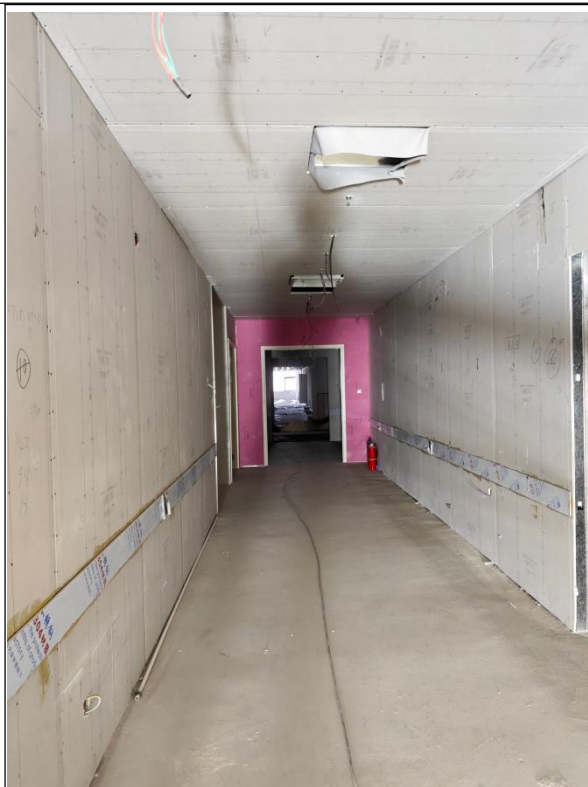
拟建址北侧（洁净通道）
