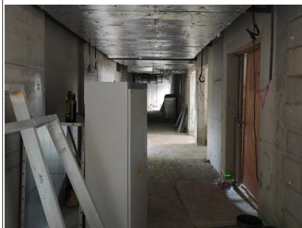
拟建址下方（会议室、过道）
