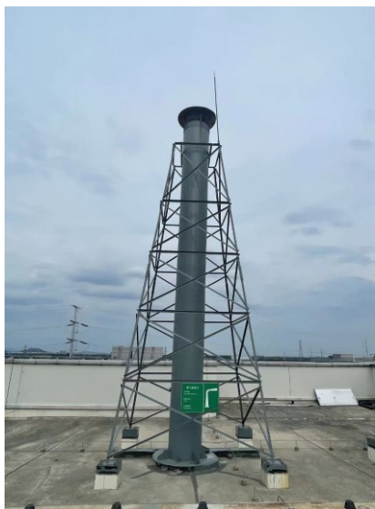
DA004 废气处理设施（氮氧化物、氟化物、醋酸）
