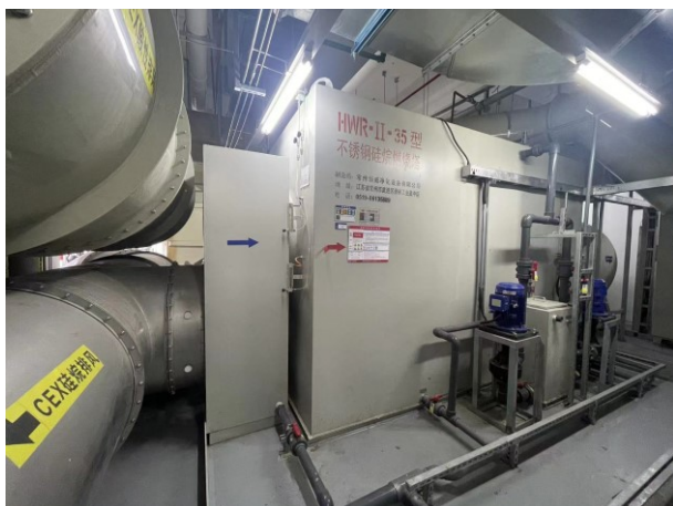
DA005 废气处理设施（硅烷、颗粒物）
