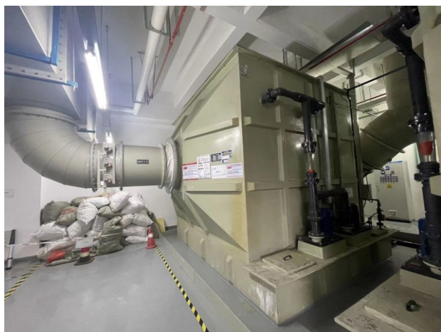
DA007 废气处理设施（HCl、HF 和 Cl 2 ）
