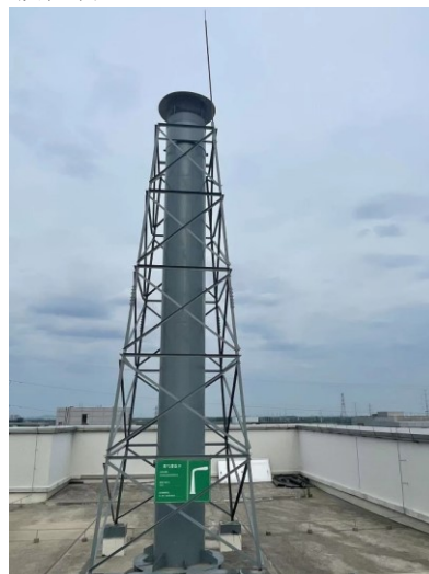
DA007 废气处理设施（HCl、HF 和 Cl 2 ）
