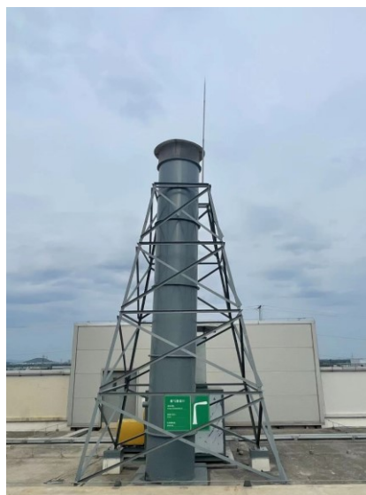
DA005 废气处理设施（硅烷、颗粒物）
