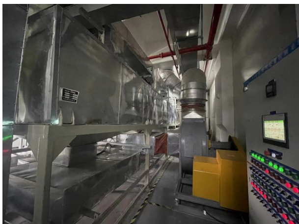
DA008 废气处理设施（有机废气）
