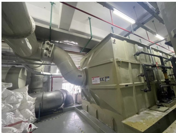
DA004 废气处理设施（氮氧化物、氟化物、醋酸）
