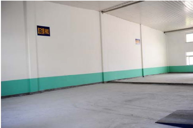
危险固废堆场
