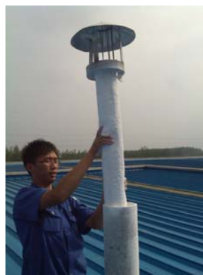
PTA布袋除尘装置
