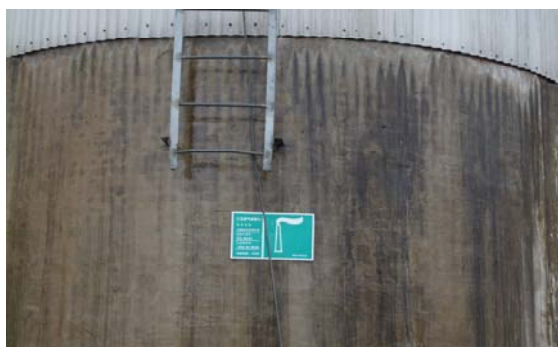
热媒炉废气排放口标识
