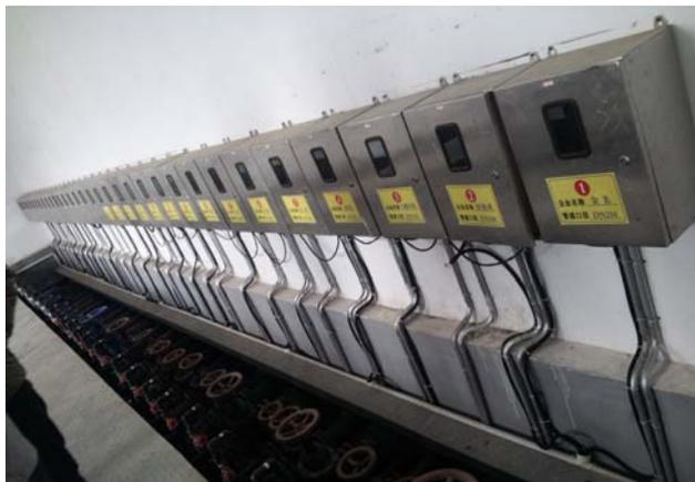
图 2.2-1 启东滨江精细化工园区污水处理厂加强各企业来水管理
