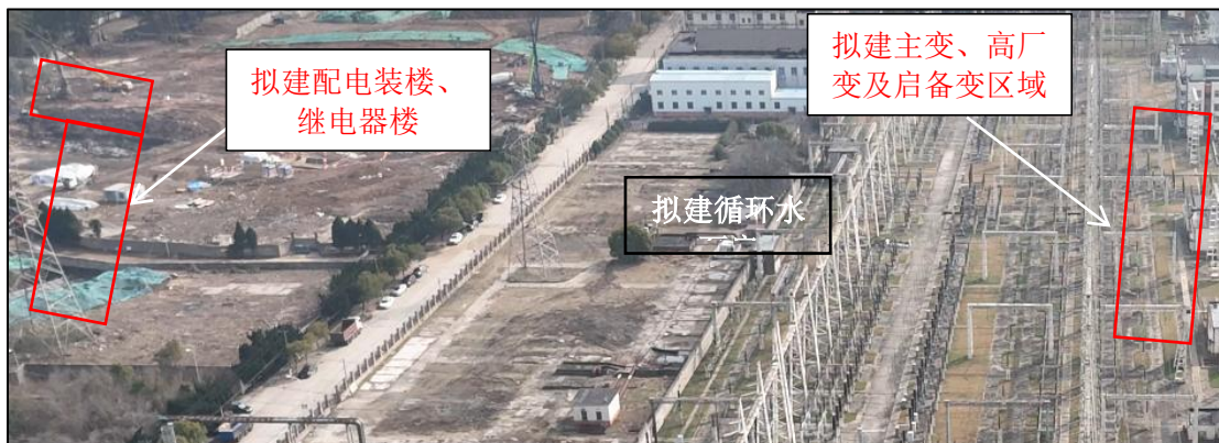
图 3-5 新建八期升压站区域现状照片
