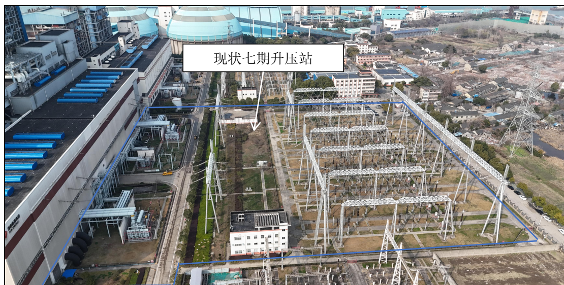
图 3-1 现状七期升压站现状照片
