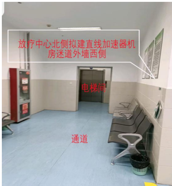
图 8-14 放疗中心北侧拟改建直线加速器机房（2#机房）西侧
