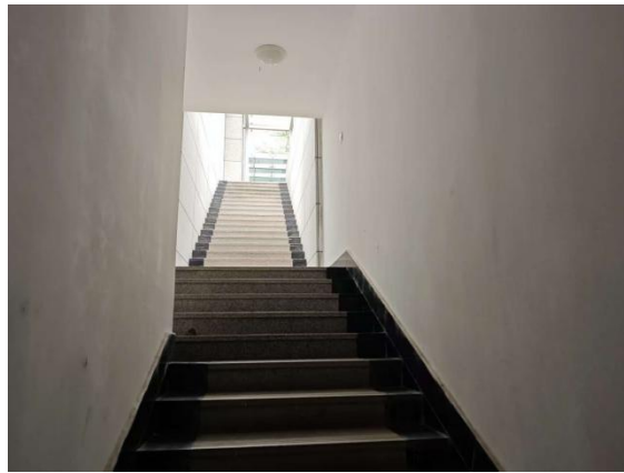
图 8-12 放疗中心 2#机房北侧通道
