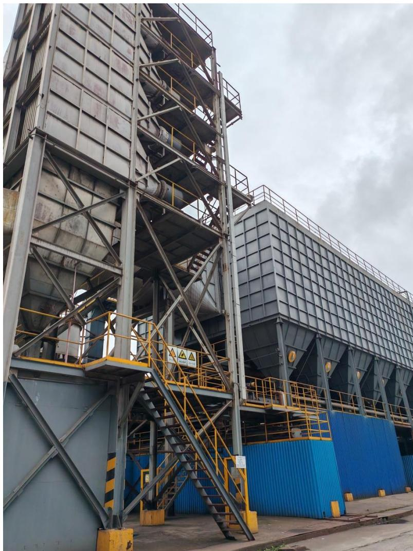
图 8.1-4 低压脉冲布袋除尘器（现有脱磷炉配套）
