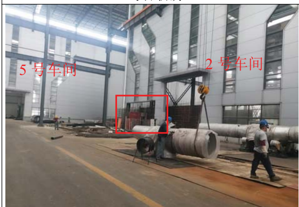
2 号探伤房拟建址
