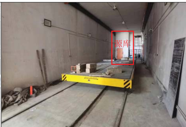
1 号探伤房内部及源库
