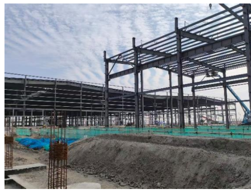
1#~4#探伤房及放射源暂存库拟建址南侧 (厂内道路)
