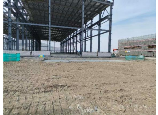
5#、6#探伤房拟建址西侧 (厂内道路)
