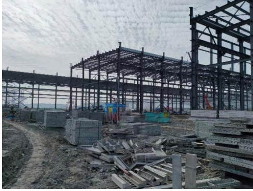
1#~4#探伤房及放射源暂存库拟建址西侧 (厂内道路)
