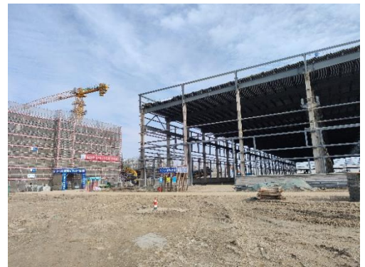
5#、6#探伤房拟建址东侧 (厂内道路)
