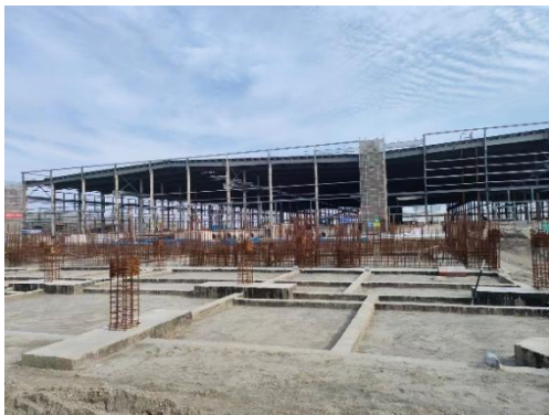
1#~4#探伤房及放射源暂存库拟建址现状
