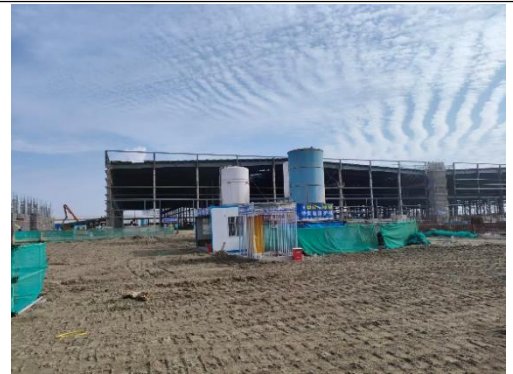
5#、6#探伤房拟建址现状
