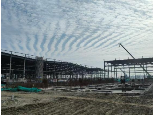
5#、6#探伤房拟建址南侧 (厂内道路)
