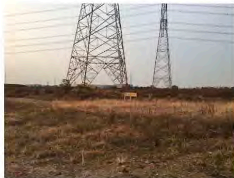
项目厂区高压线
