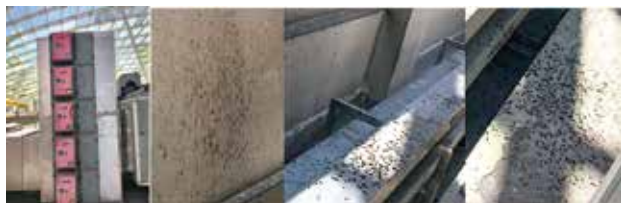
改造前电控箱设施损坏及风口喷油情况
