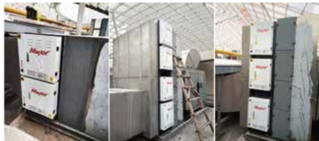
改造前电控箱设施损坏及风口喷油情况
