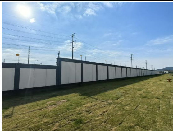
实体围墙及局部加高措施
