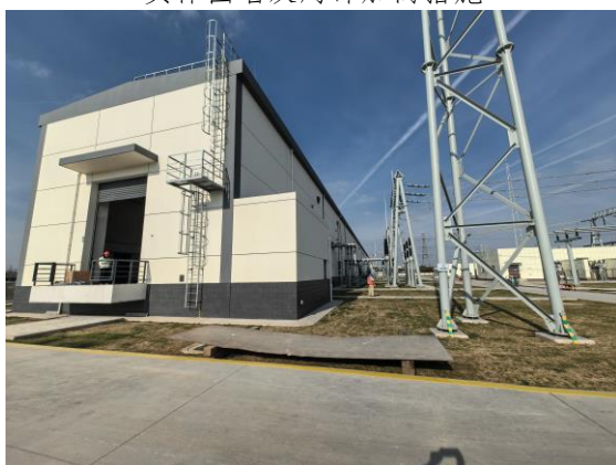
220kV 户内 GIS 室
