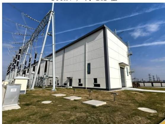
2#主变事故油池
