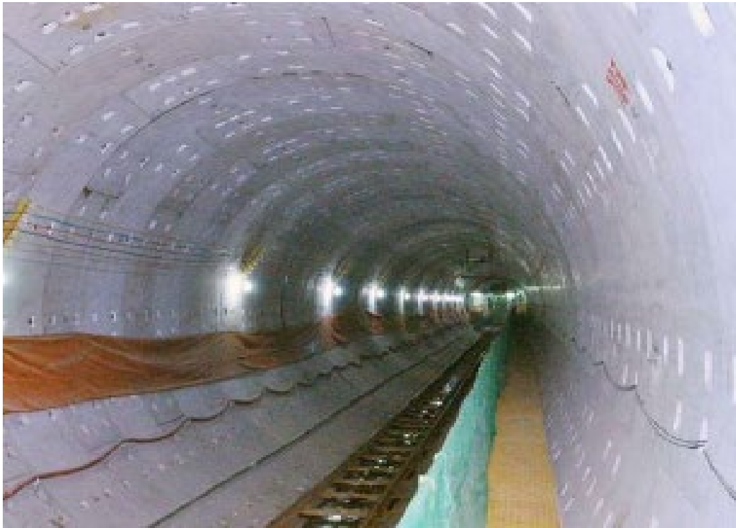
图 4.4.1-3 盾构法施工内部施工现场
