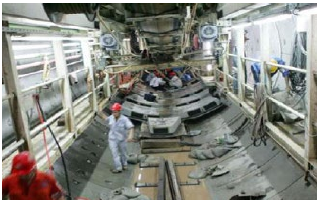
图 4.4.1-2 盾构法施工内部施工现场
